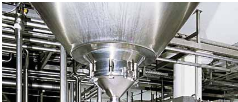
Budowa zbiorników i instalacji
